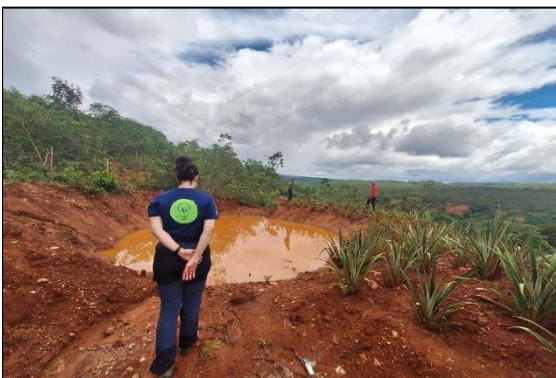
Bacia de contenção implantada. Autoria: Luísa Mosqueira Data: 25/02/2026
