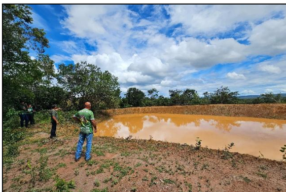
Barragem implantada na propriedade. Autoria: Carolina Rodrigues Bordignon Data: 25/02/2026
